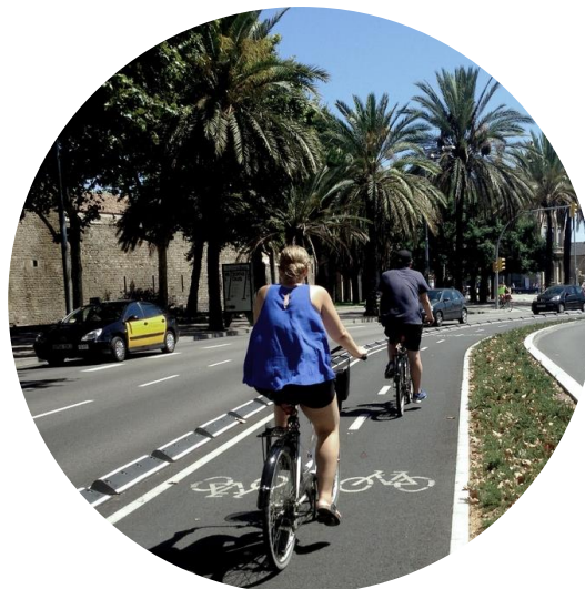
Exemple. Aménagement de bande cyclable sécurisée.
