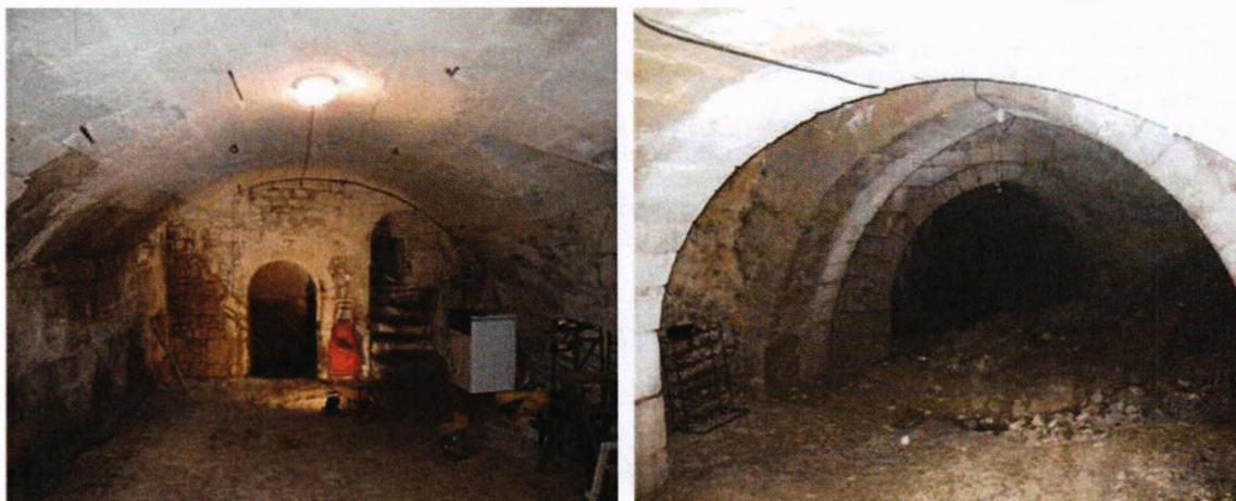
Illustration 5 : cavités du centre-ville parées de pierres de taille et voûtées.
