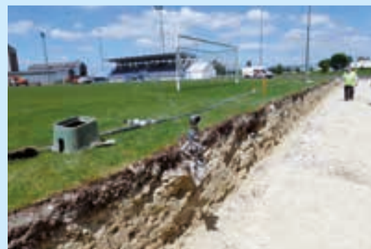
Pendant les travaux
